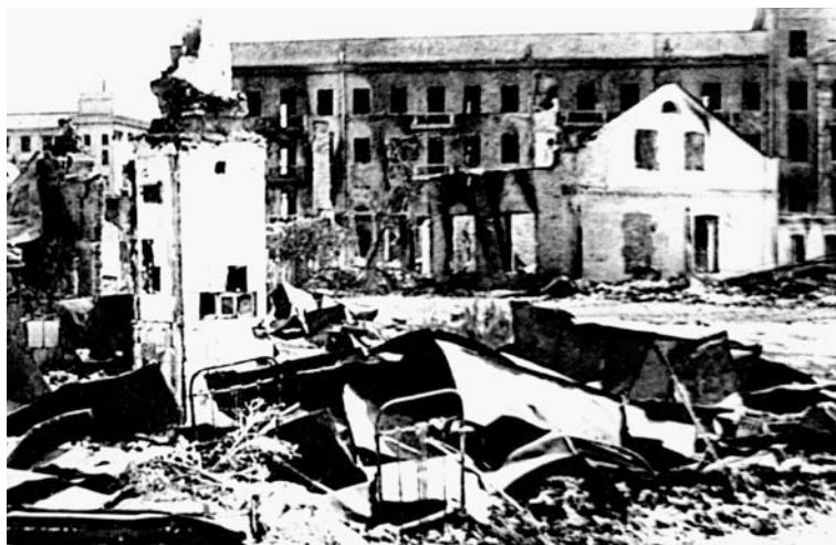
Разрушенные жилые дома по ул. Миронова в г. Могилеве. БГАКФФД.
