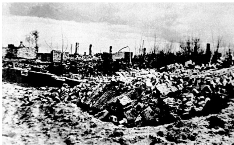
Разрушенные жилые дома по ул. Пушкина в г. Бобруйске. БГАКФФД.
